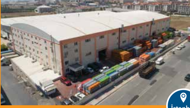
Vana ve PP-R Sistem Üretim Tesisi
