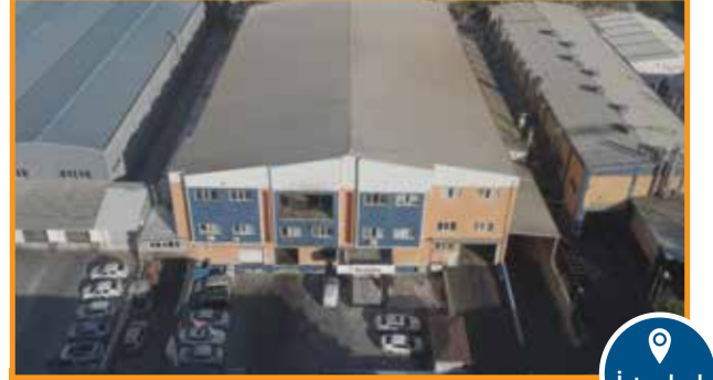
Metal Üretim Tesisi
